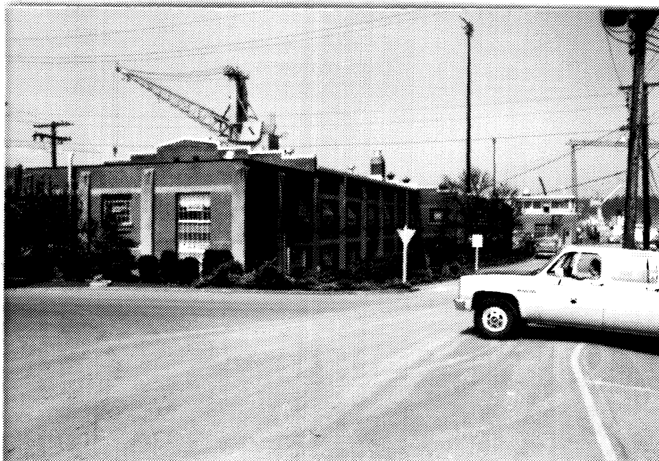
9 Left-to-right: D191A, D191, D191B, D190A, eastern elevation looking north. (Ian Doull, AHB, Parks, 1989.)
